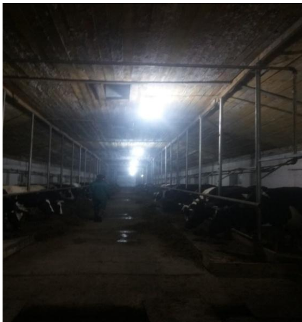
Рисунок 5.4 – Животноводческое помещение и расположение в них люминесцентных ламп марки SPIRAL 85
